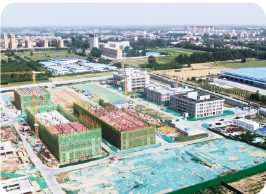
坤泽药业建设现场
