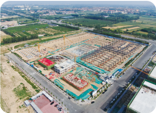
海希储能建设现场
