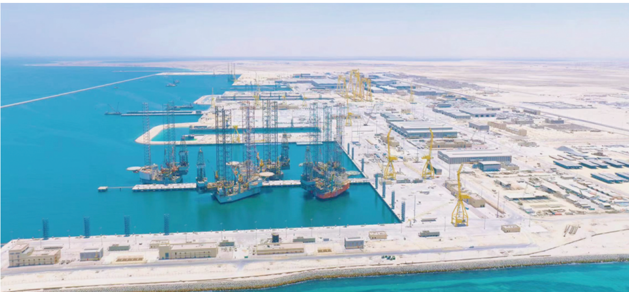
山东电建EPC总承包的沙特萨勒曼国王国际综合港务设施项目
