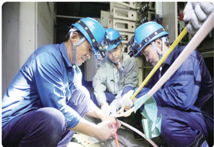
2021年7月26日，国网山东电力豫豫人员在郑州市绿洲银郡小区开展抢修工作。 摄影：罗涛
