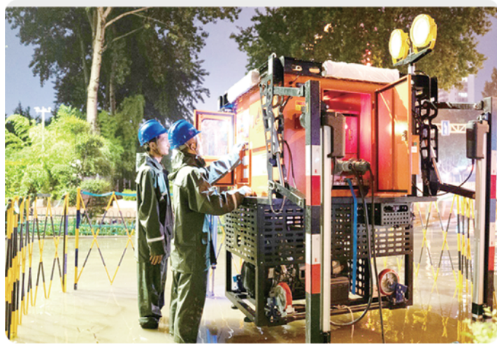
2024年7月7日，国网临沂供电公司员工雨后第一时间对变电站电缆通道进行抽排水作业。 摄影：主汉卿
