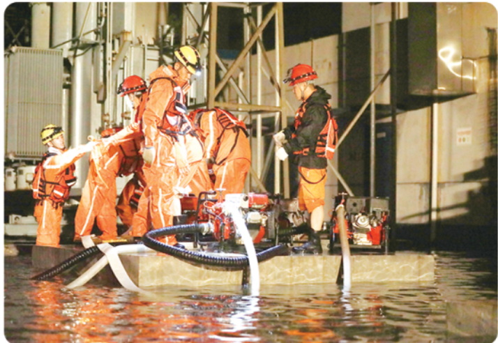
2019年8月，台风“利奇马”过境，国网山东电力应急救援基分队连夜开展变电站紧急排水。 摄影：王明军
