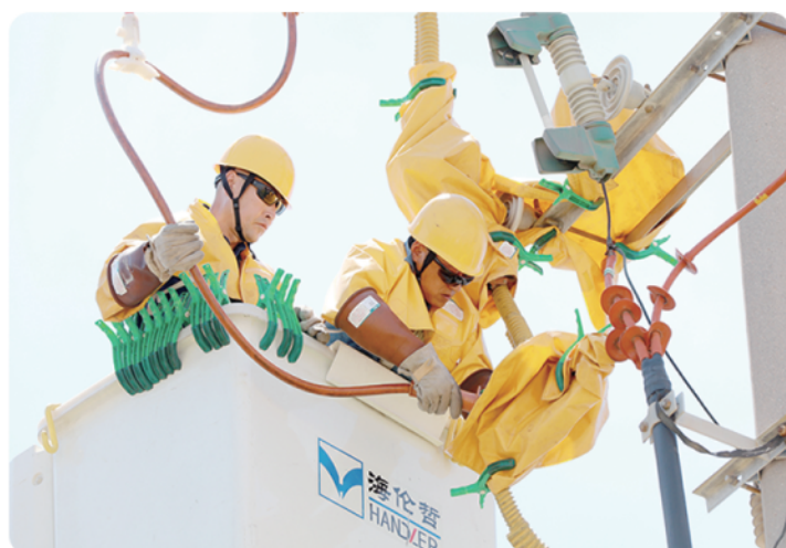
2024年7月，国网威海供电公司作业人员在10千伏光华线开展带电作业，消除线夹发热隐患。 摄影：刘中华
