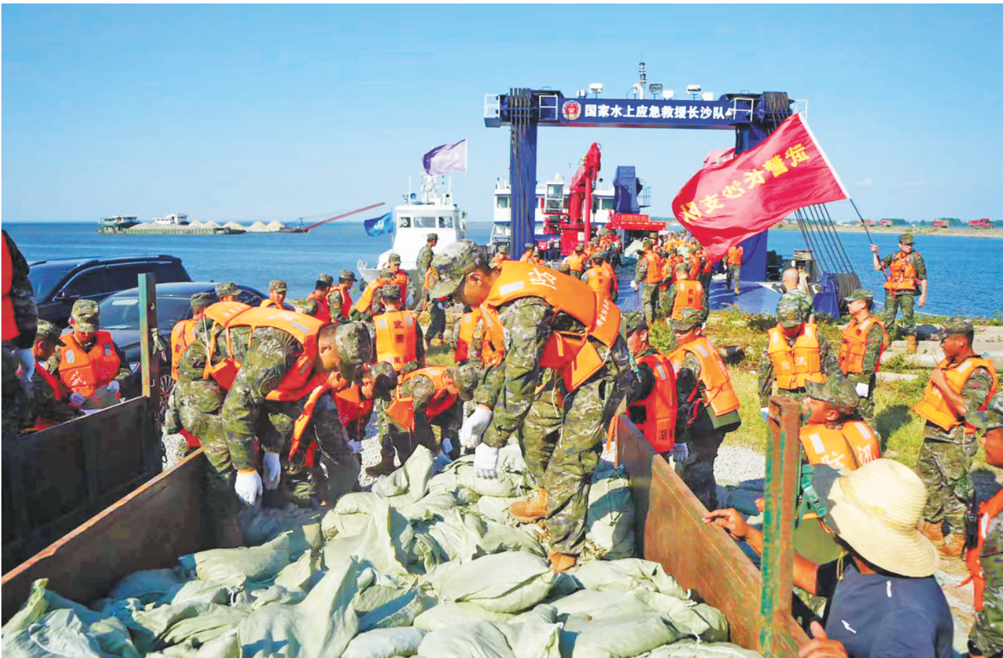
7月6日，武警湖南总队官兵在湖南省岳阳市华容县团洲垸受灾现场第二道防线搬运沙袋加固堤坝。
