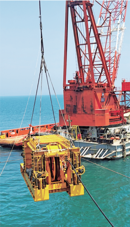
杰瑞集团生产的水下导向攻泥器出海作业
