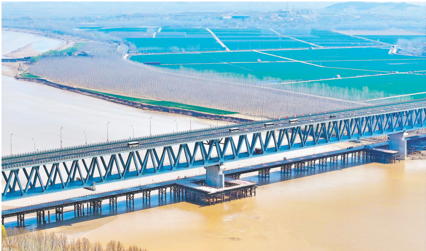
3月26日，车辆行驶在建邦聊泰黄河公铁大桥上。当日，建邦聊泰黄河公铁大桥正式通车。（□新华社发）
