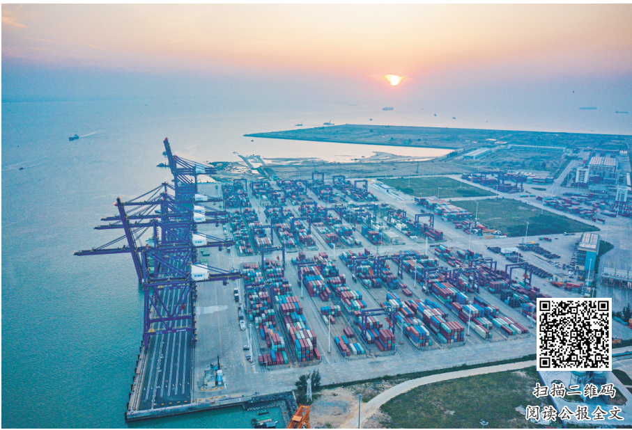
2023年11月27日拍摄的海南省洋浦经济开发区洋浦国际集装箱码头。
