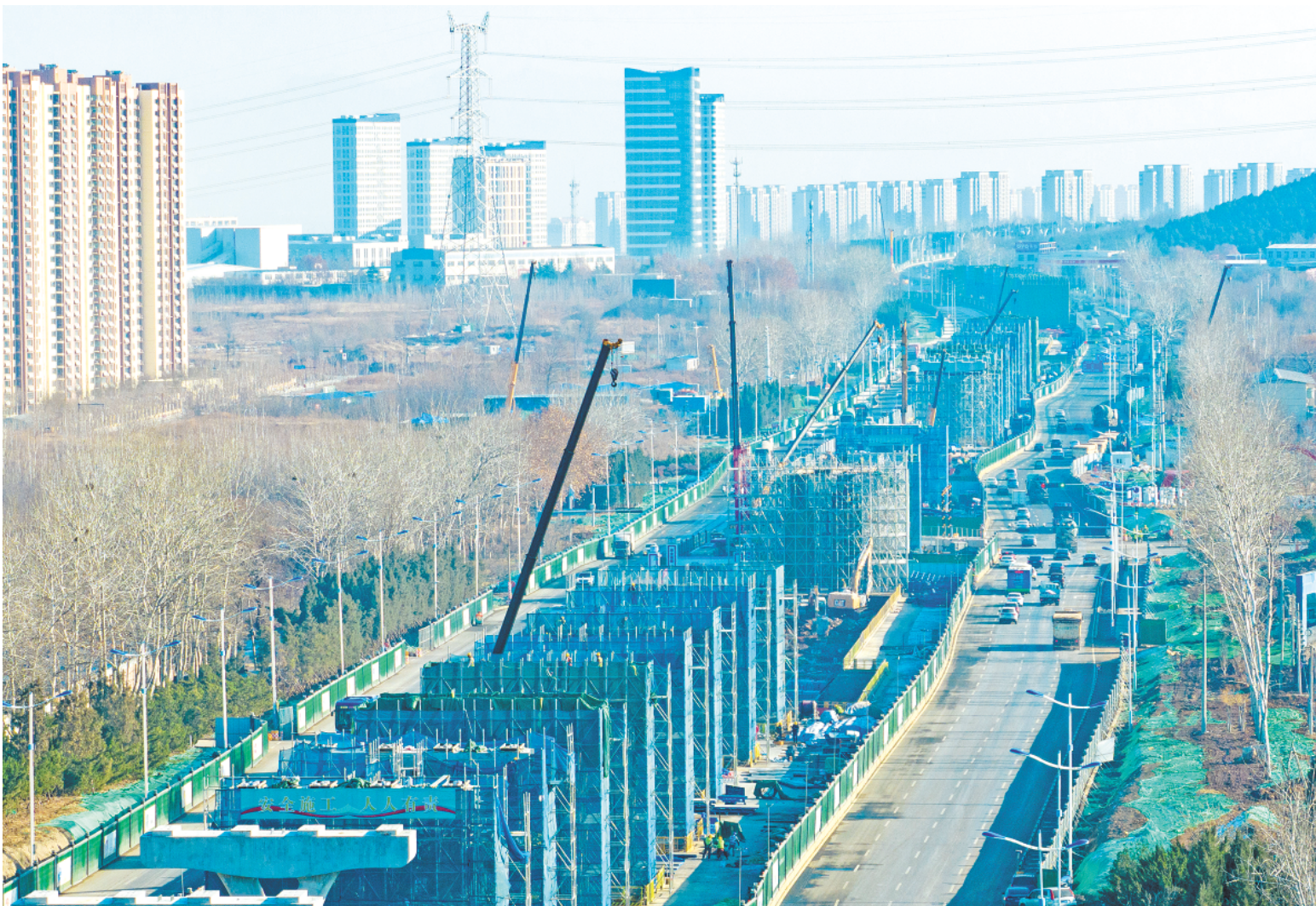
新春伊始，济南各项目施工现场，一派热火朝天的忙碌景象，建设者铆足干劲力争实现龙年“开门红”。图为济南轨道交通8号线一期工程施工现场。目前，该项目高架段墩柱施工完成75%，U梁预制生产完成60%，架设完成31%，地下段5台盾构机全部始发，正稳步向前推进。
