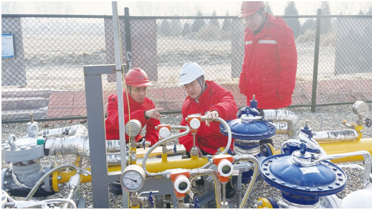
◀ 2024年春节前夕，山东油气开展安全生产专项检查。
