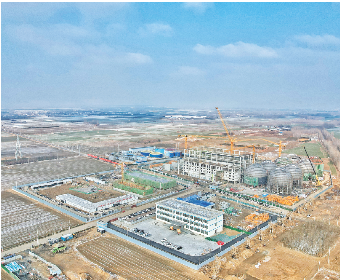
□记者 刘涛 通讯员 陈阳 报道 日前，位于肥城市的中储国能300MW压缩空气储能电站项目正在有序建设中。该项目建成后，将成为全球首个300MW级先进压缩空气储能商业电站。
