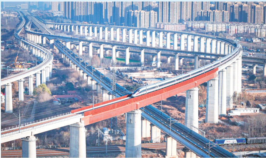
图为列车驶过济郑高铁跨京沪高铁特大桥。(□资料片)
