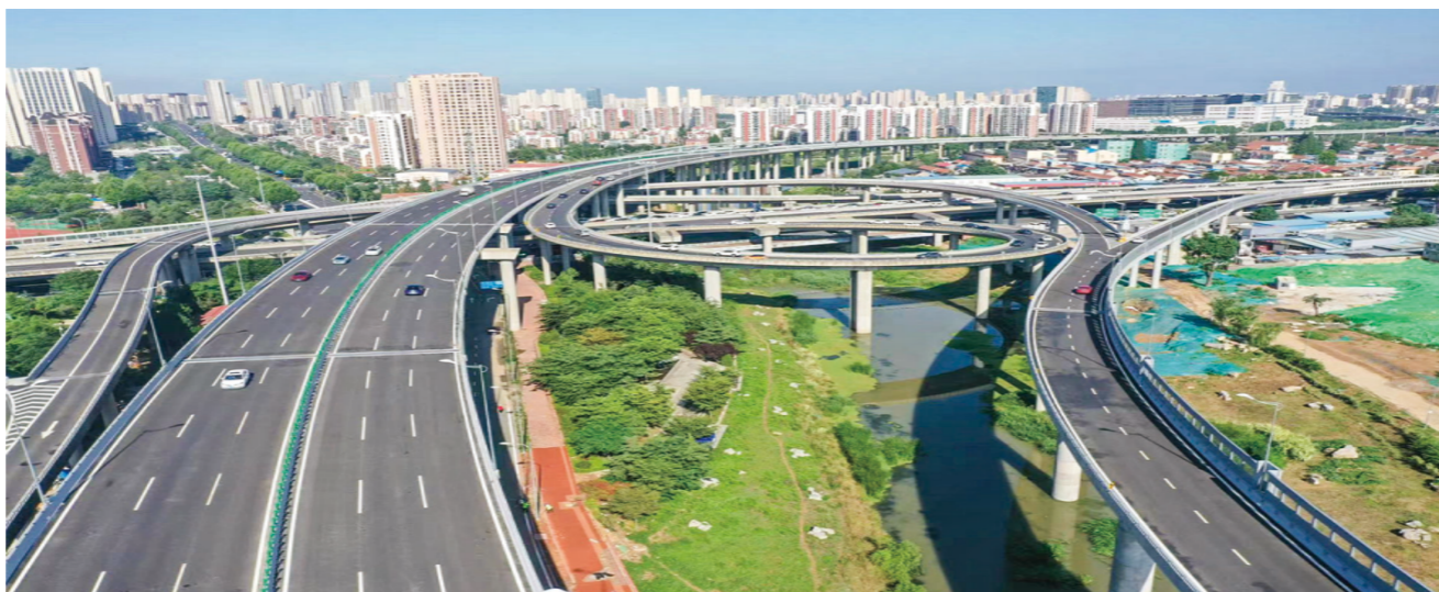
跨海大桥高架路二期建成通车
