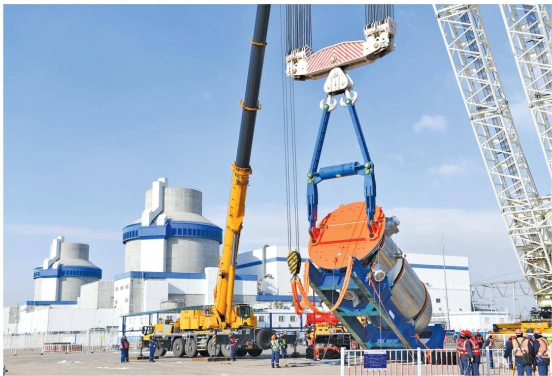
12月21日16时23分,海阳核电3号核岛反应堆压力容器筒体吊装就位,这是3号核岛吊装就位的首个大型主设备,为3号核岛反应堆一回路主系统安装高峰拉开了帷幕。反应堆压力容器筒体吊装就位是海阳核电3号机组2023年度完成的重要收官节点,为后续3号核岛反应堆一回路主管道安装工作的顺利开展提供了有力保障。
