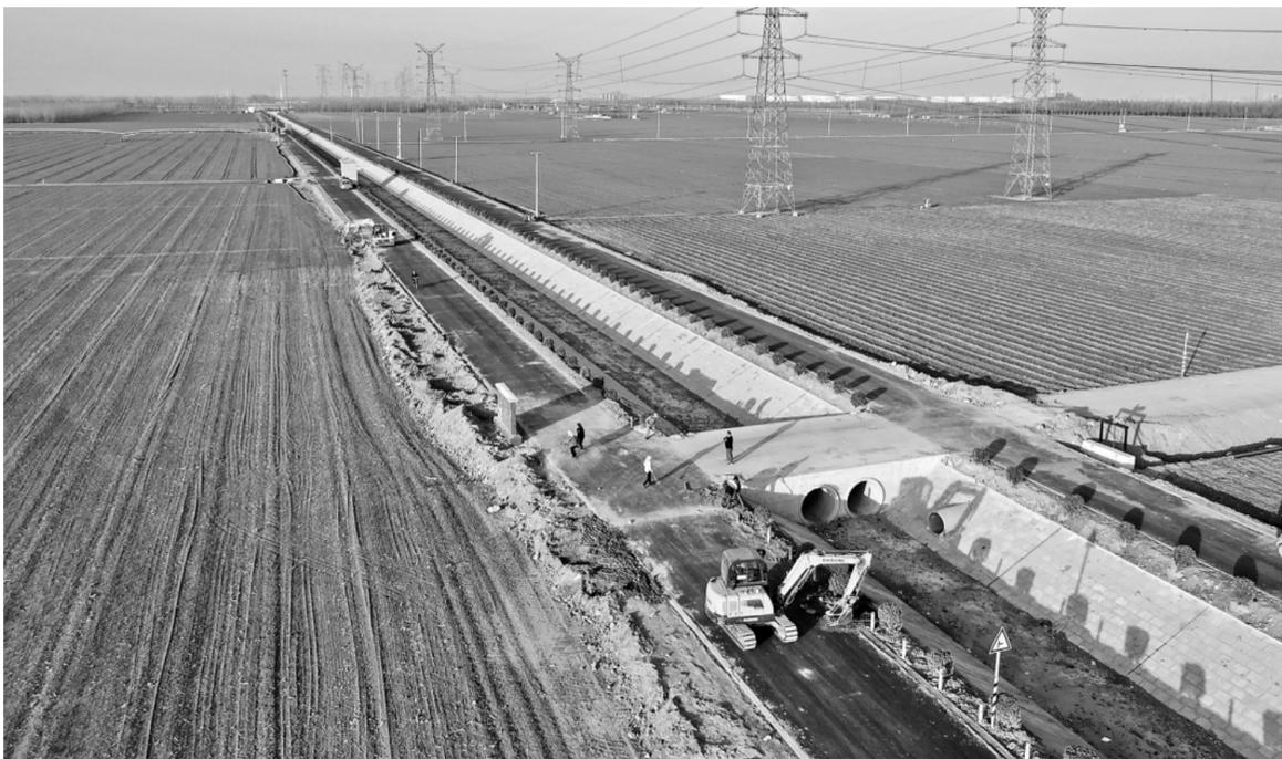
近日，广饶县李鹊镇高标准农田建设现场，施工人员正在加快田间道路建设及铺设田间供水管道。利津县今年投资5300余万元建设2.23万亩高标准农田，铺设低压管道32.87公里，硬化田间道路20.38公里，以及建设其他配套设施，项目完工后新增高效节水灌溉1.33万亩，年实现节水53.7万立方米。
