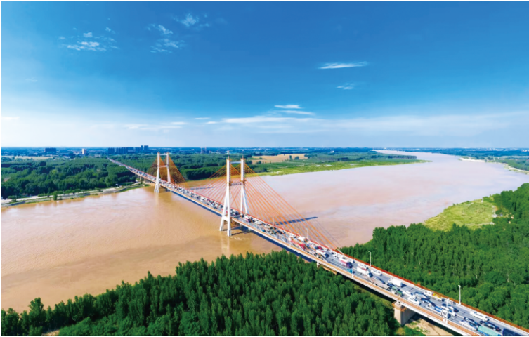
济南黄河公路大桥
