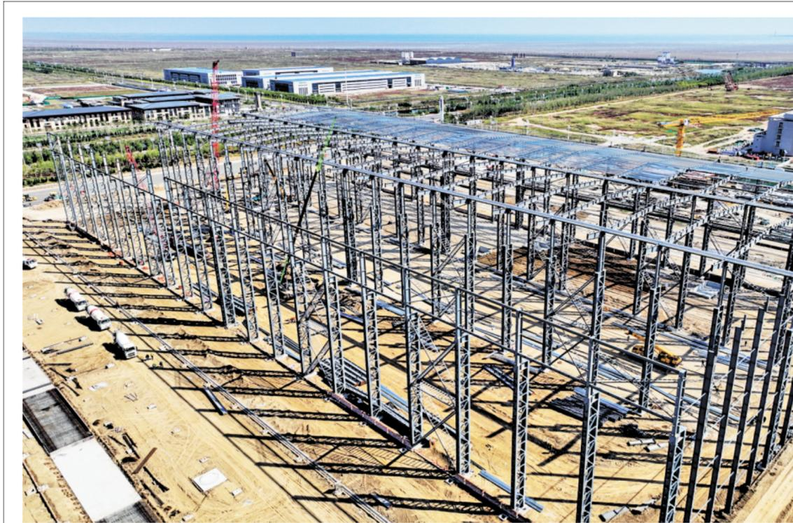
10月12日,位于东营经济技术开发区东营海上风电产业园的江苏海力海上高端装备制造基地项目正在进行钢结构厂房施工。据了解,该项目计划总投资10亿元,占地200亩,主要布局海上风电装备制造塔筒、单桩(桩基)、导管架及升压站等设备。项目达产后预计年收入20亿元、利税2.6亿元,解决就业人口500余人。
