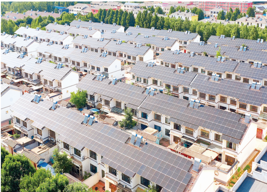
齐河县华店镇屋顶分布式光伏项目俯瞰图。
