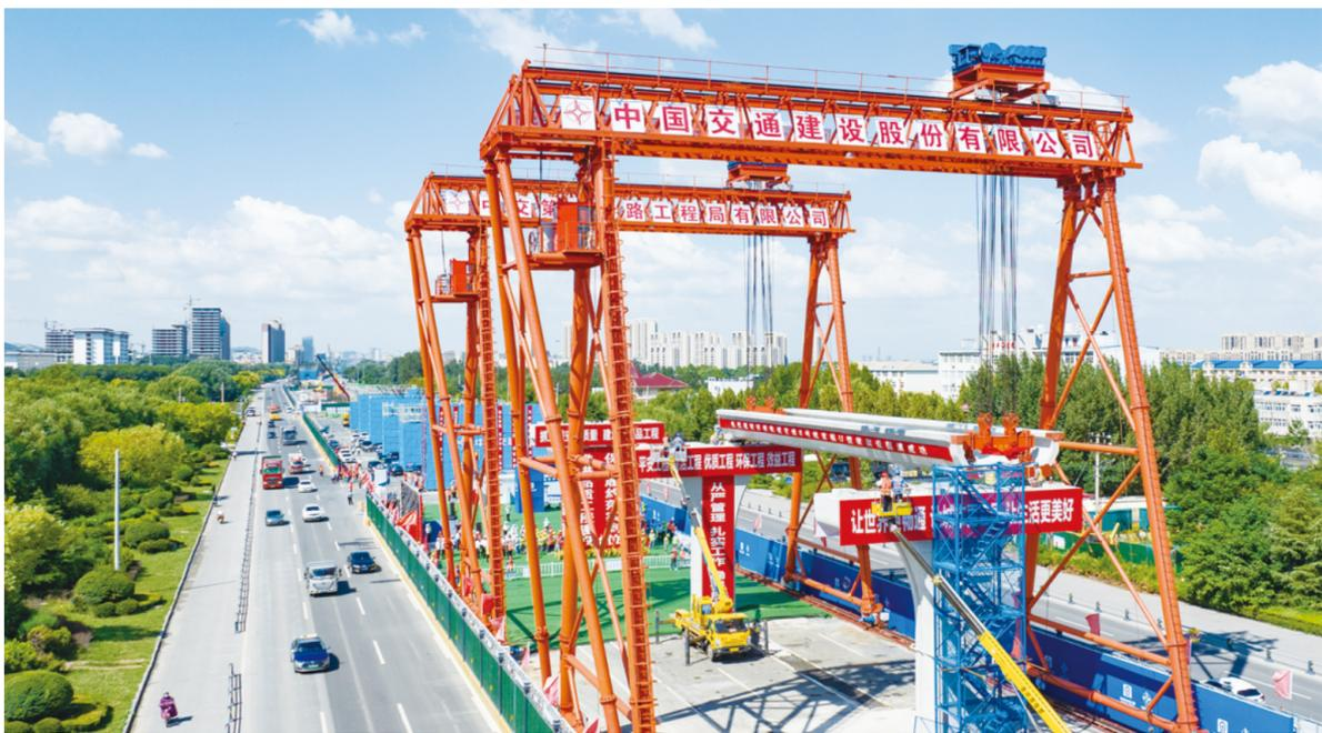
9月20日上午，济南轨道交通8号线一期首幅U形梁架设成功，标志着项目进入线上线下平行施工阶段。据悉，8号线一期工程途经历城区、高新区和章丘区，沿经十东路走行，连接自贸试验区济南片区、齐鲁科创大走廊、章丘大学城、明水经济技术开发区，建成后对方便沿线市民出行、促进中心城区和东部城区经济社会协调发展具有重要意义。
