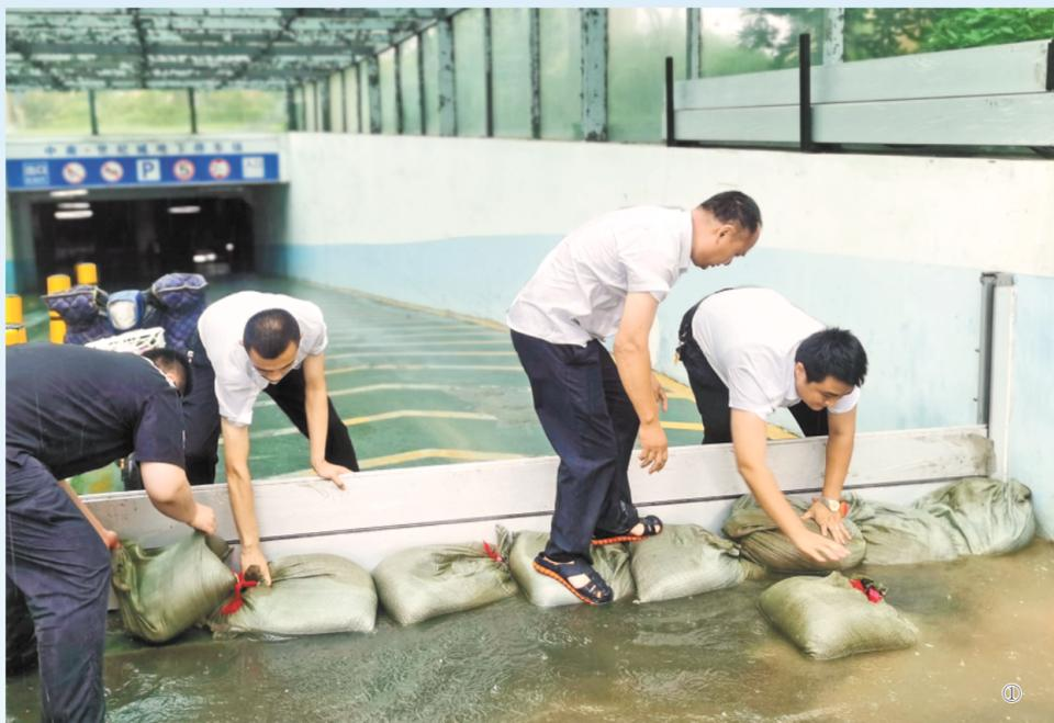
图①:东营渤海御苑物业工作人员在地下车库出入口安装防水挡板。图②:国网济南供电公司工作人员正在所辖变电站雨前巡视设备运行情况。图③:济南地铁工作人员测试排水泵。(□记者 陈巨慧 张楠 通讯员 张治林 韩宁 党鑫毅 报道)
