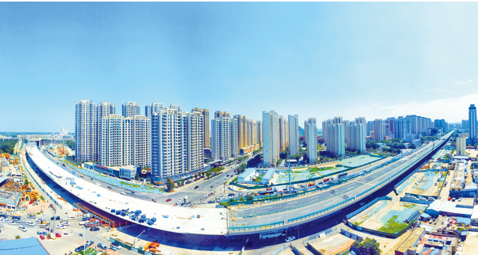
零点立交与二环东高架路成功“牵手”。零点立交拆除重建是济南黄河公路大桥扩建工程的重要组成部分，8月8日，在济南零点立交施工现场，记者看到新建的零点立交已与二环东高架路实现了对接。零点立交共设14条匝道，是省内首座“三通”满轮形枢纽立交，可实现高速公路、城市快速路和城市主干路三者间的转换。
