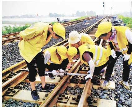
□记者 李明 通讯员 石若琳 报道 近日,中铁十五局轨道交通运营公司山东铁路维管处认真开展以“防胀防塌”“防火防暑”为主题的夏日安全专项行动,逐个击破安全隐患。图为作业人员正在进行道岔测量支距测试。
