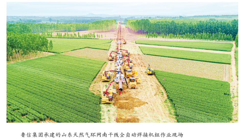
鲁信集团承建的山东天然气环网南干线全自动焊接机组作业现场
