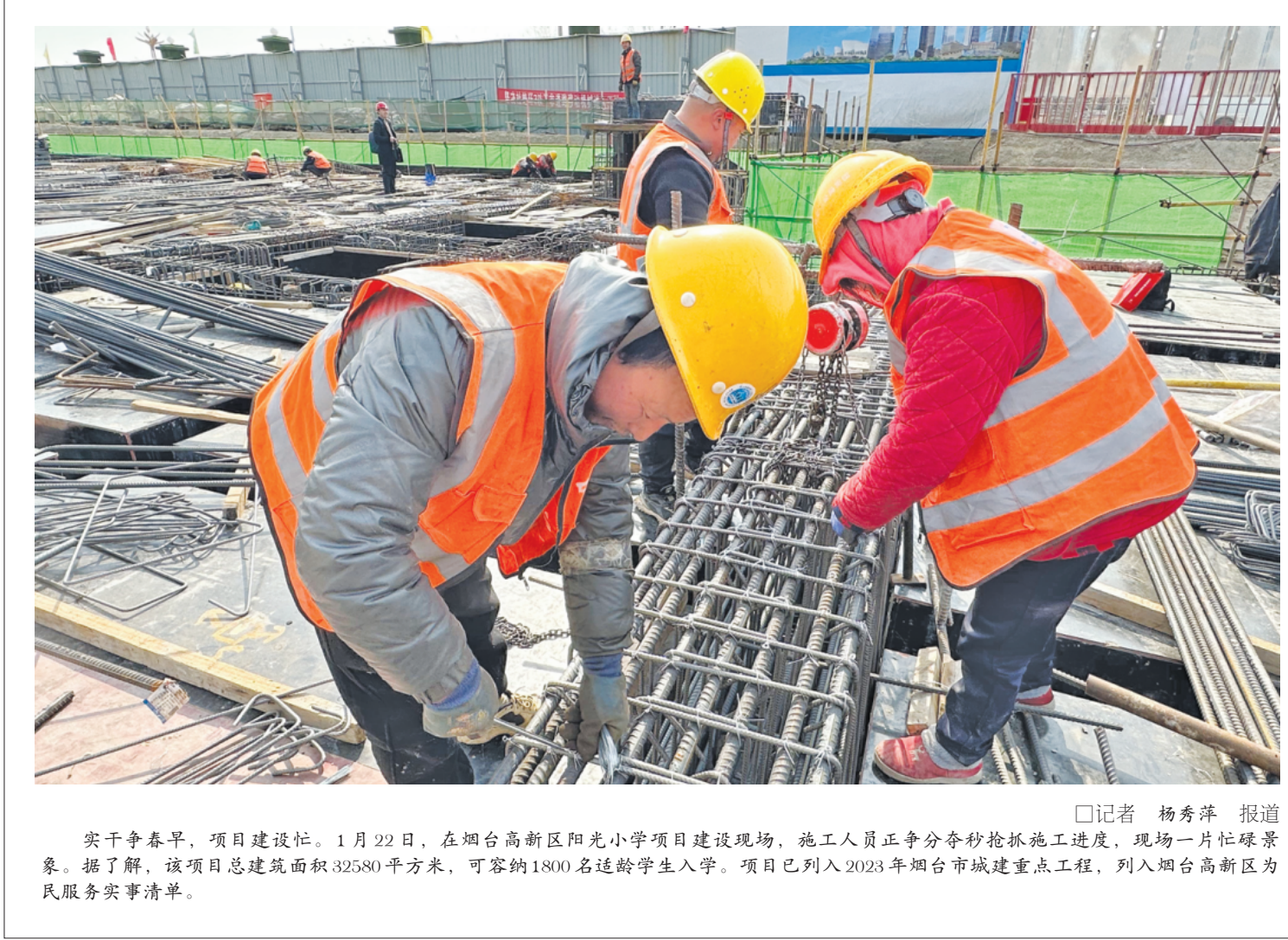
□记者 杨秀萍 报道 实干争春早，项目建设忙。1月22日，在烟台高新区阳光小学项目建设现场，施工人员正争分夺秒抢抓施工进度，现场一片忙碌景象。据了解，该项目总建筑面积32580平方米，可容纳1800名适龄学生入学。项目已列入2023年烟台市城建重点工程，列入烟台高新区为民服务实事清单。
