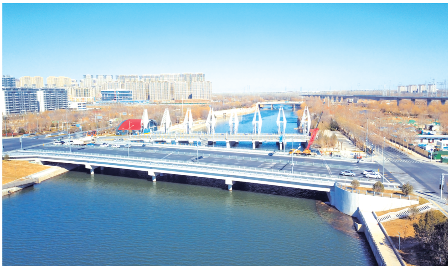
小清河再添新桥。近日，奥体西路北延跨小清河桥在竣工验收后正式通车。该桥型采用预制工字梁桥，分别跨越南水北调输水涵洞和小清河。该项目是奥体西路北延的重要节点工程，是济乐高速与市区快速连接的重要通道。
