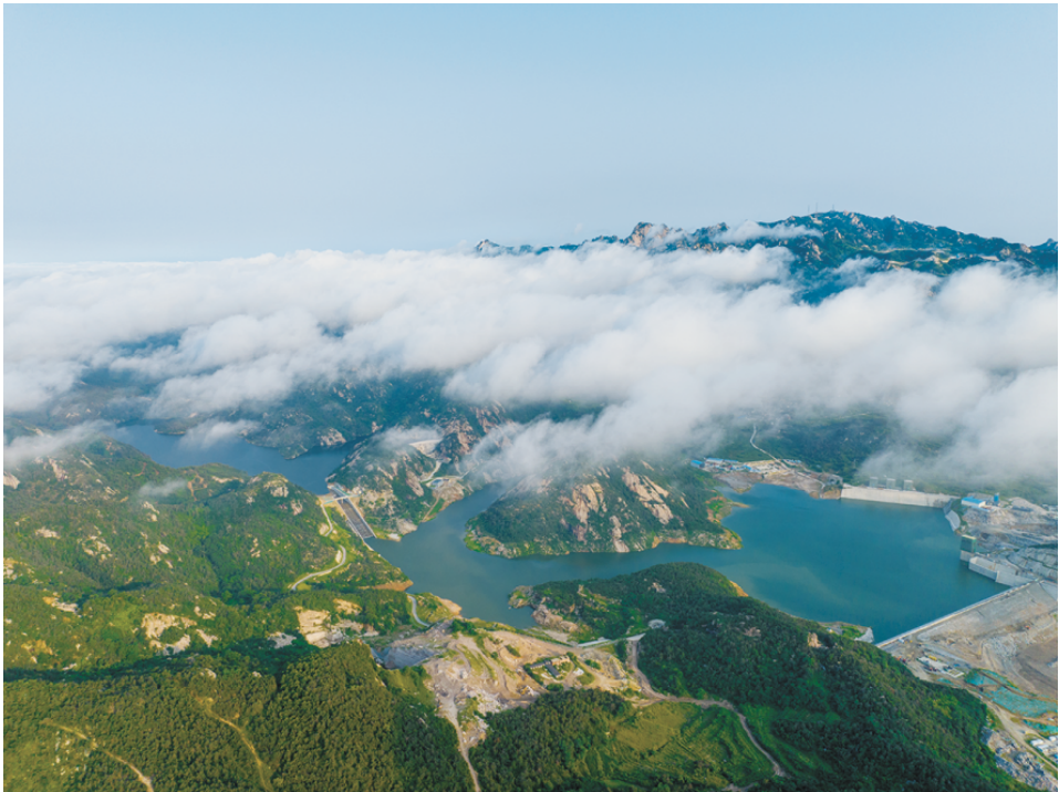
山东文登抽水蓄能电站俯瞰图。
