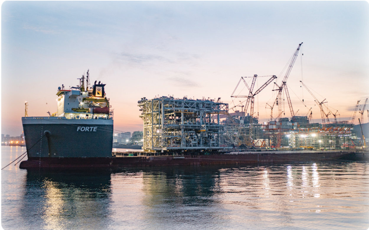
全球首例一体化建造 LNG 工厂首个核心工艺模块在青岛西海岸新区启航
