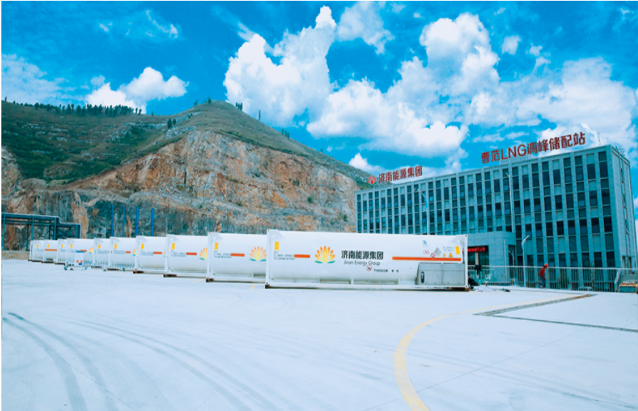
济南南曹范LNG调峰储配站现场图。
