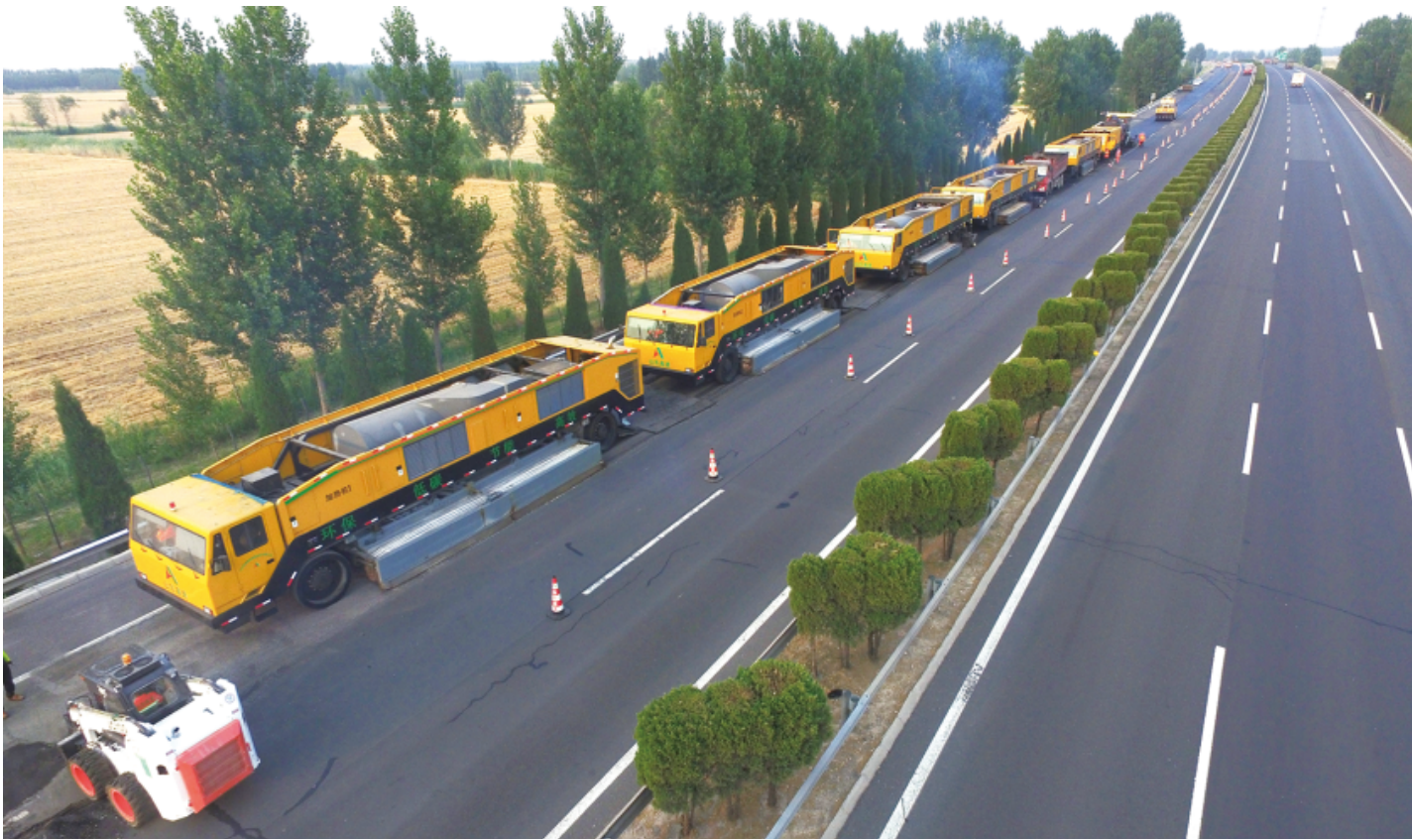
沥青路面就地热再生机组
