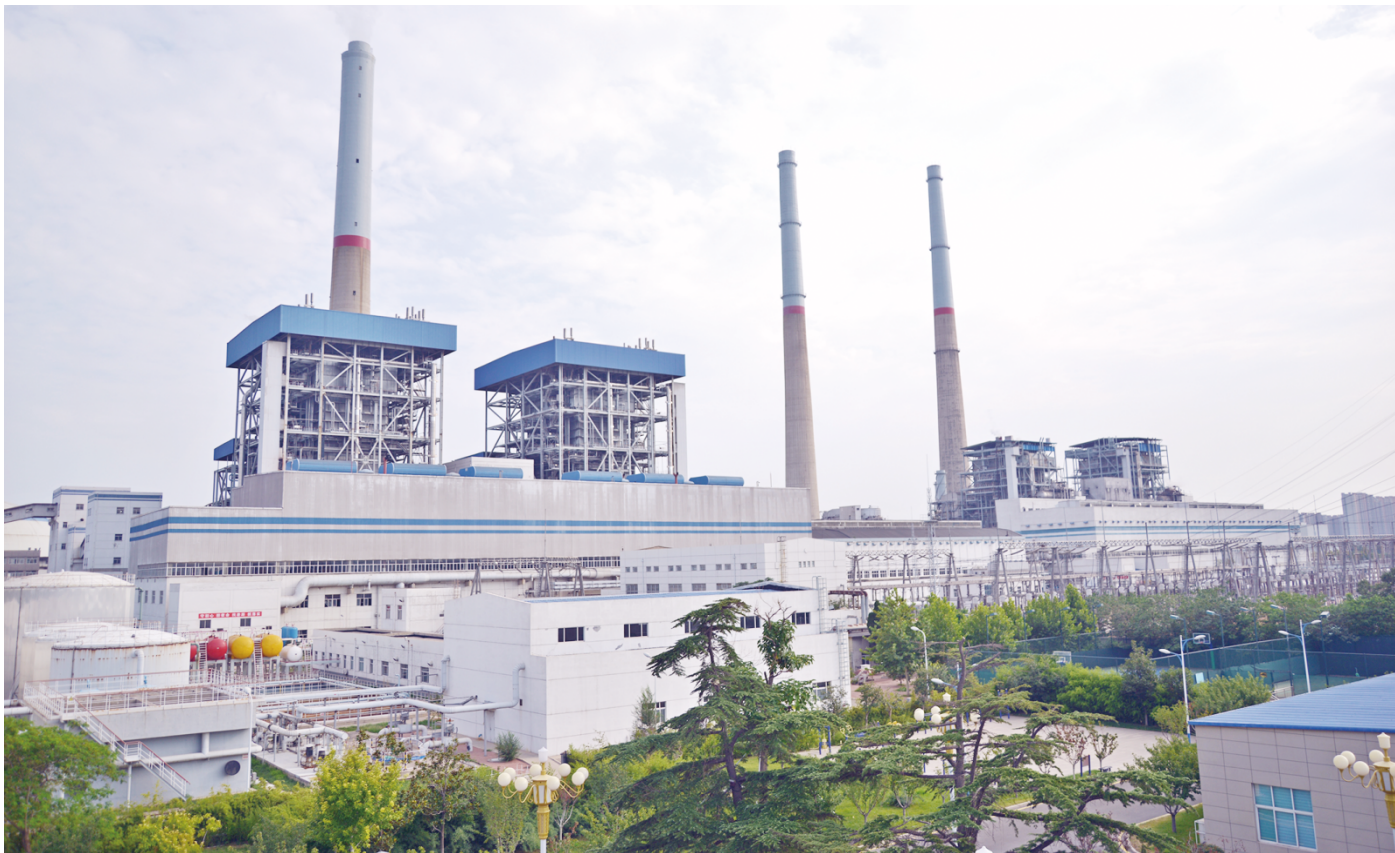
华能黄台电厂厂区。
