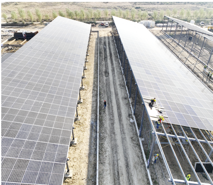
华能高青唐坊300兆瓦牧光互补项目施工现场。
