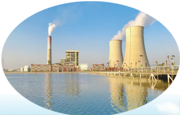
巴基斯坦萨希瓦尔燃煤电站项目是山东信保支持的首个全部由中资企业投资建设的中巴经济走廊电站项目
