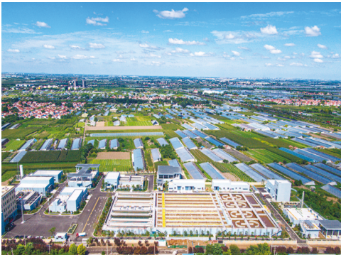
寿光市西城污水处理厂
