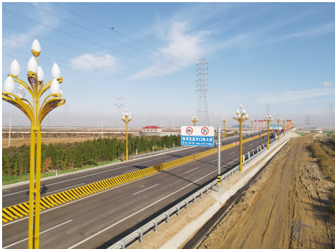
寿光市羊口特大桥
