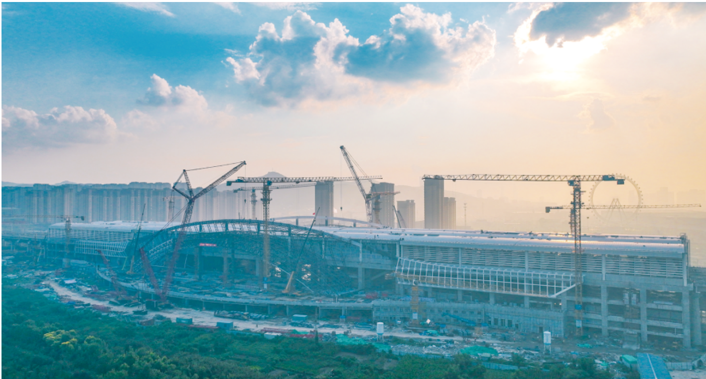
8月16日，中铁十局承建的济莱高铁历城站钢结构雨棚完成施工。三座洁白的拱形顶雨棚并列排开，如波浪翻滚的云海，沿新建济莱高铁正线南北延伸。 济莱高铁历城站是济莱高铁全线最大中间站，站房综合楼总建筑面积105774平方米，地上结构共3层，站房屋顶与站台雨棚分体设计，雨棚覆盖面积为26638平方米。
