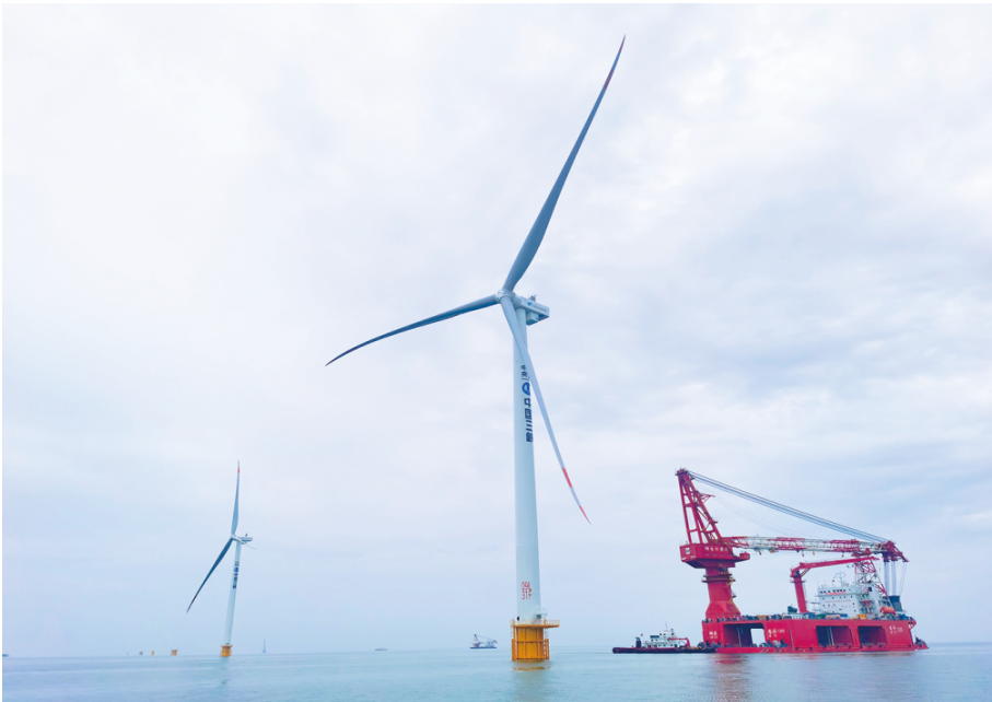
山东昌邑海上风电项目风机吊装。
