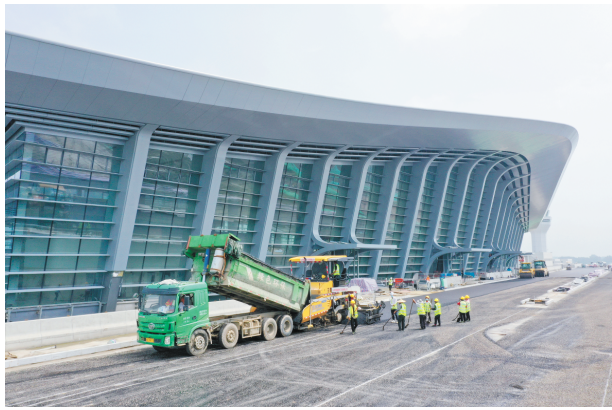
7月14日，施工人员在济宁新机场航站楼前高架路上施工。
