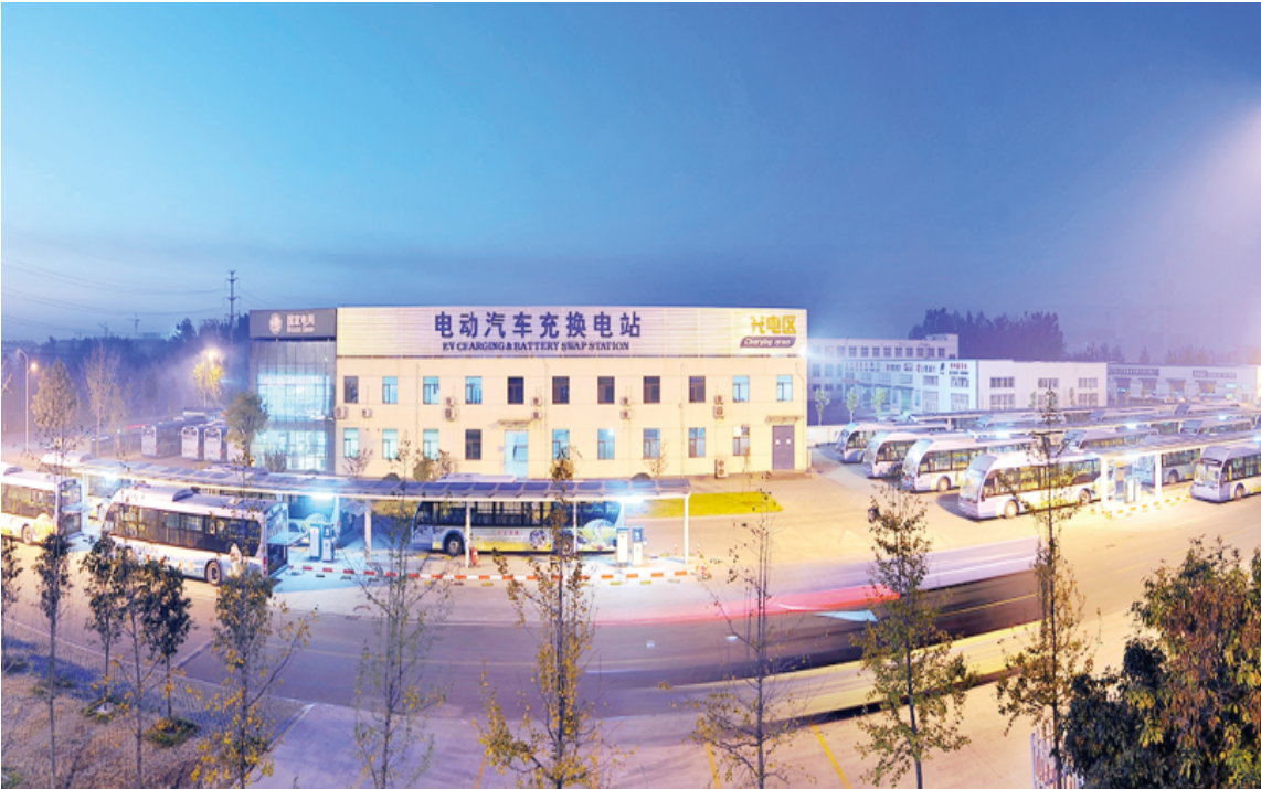
临沂焦庄电动汽车充换电站。
