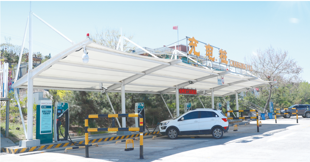
沂源高速服务区充电站。
